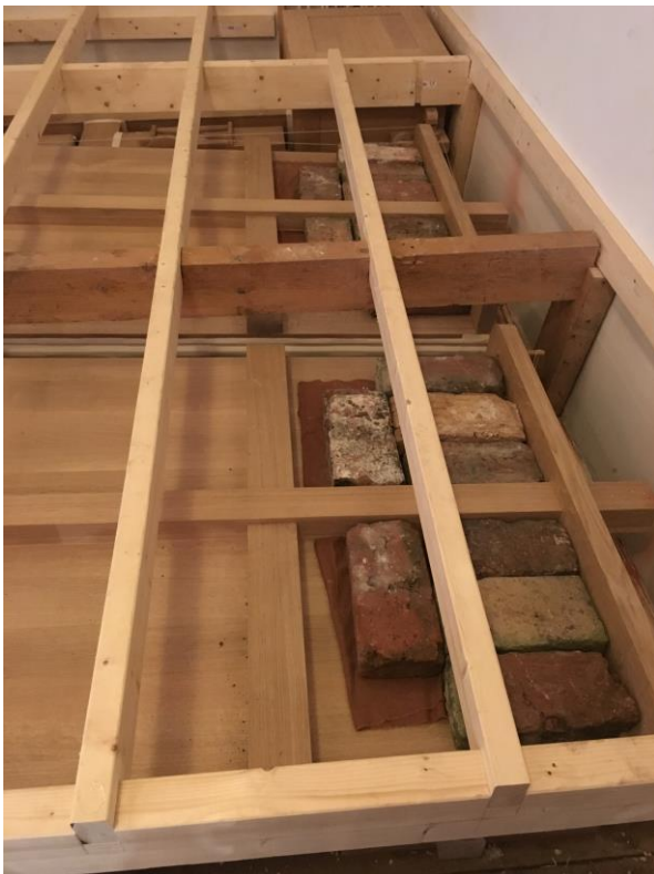
Het nieuw gemaakte balgenhuis, met balgen en echte kloostermoppen.
