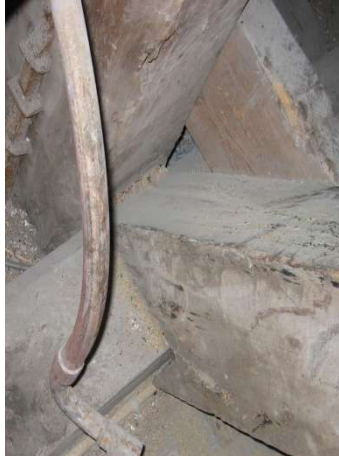
Deel van de gasleiding op het tongewelf in de Lutherse Kerk te Groningen
